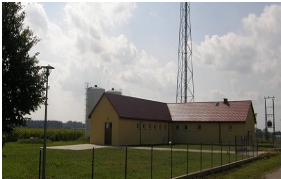
Fot. 14. Wyremontowany Budynek hydroformi w Perlejewie
